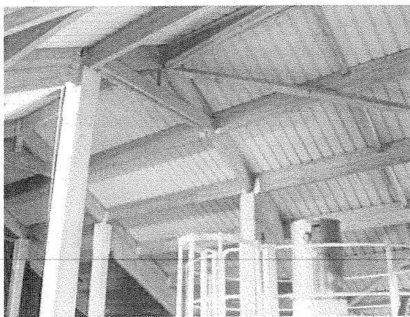
Vue de la charpente bois
