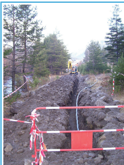
Création du réseau de raccordement au réseau électrique du PR "Pont RN94"
