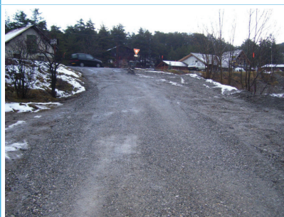
Déc.09 : réfection provisoire de la voirie - débouché sur la RN94
