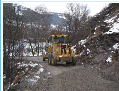
Déc.09 : réfection provisoire de la voirie
