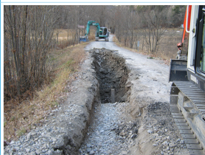
Oct - Déc.09 : Reprise des travaux de création du réseau de transfert
