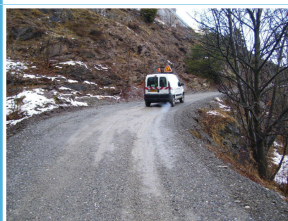
Déc.09 : réfection provisoire de la voirie
