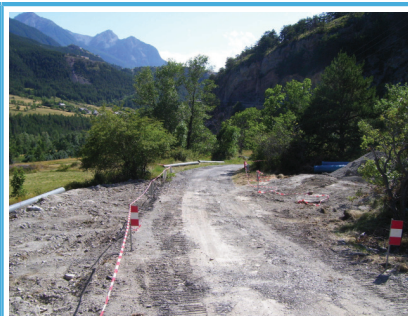
Juil.09 ; Suspension provisoire des travaux
