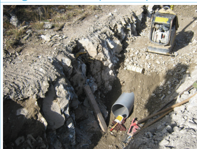
Nov.09 : pose en secteur rocheux
