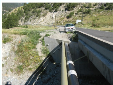
Passage en encorbellement du pont du Villard
