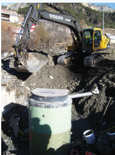
Terrassement et pose du poste de refoulement rive droite
