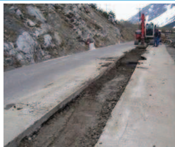
Travaux sous RD920
