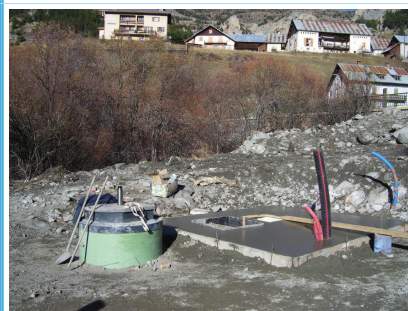
Poste de refoulement rive droite : construction du local technique
