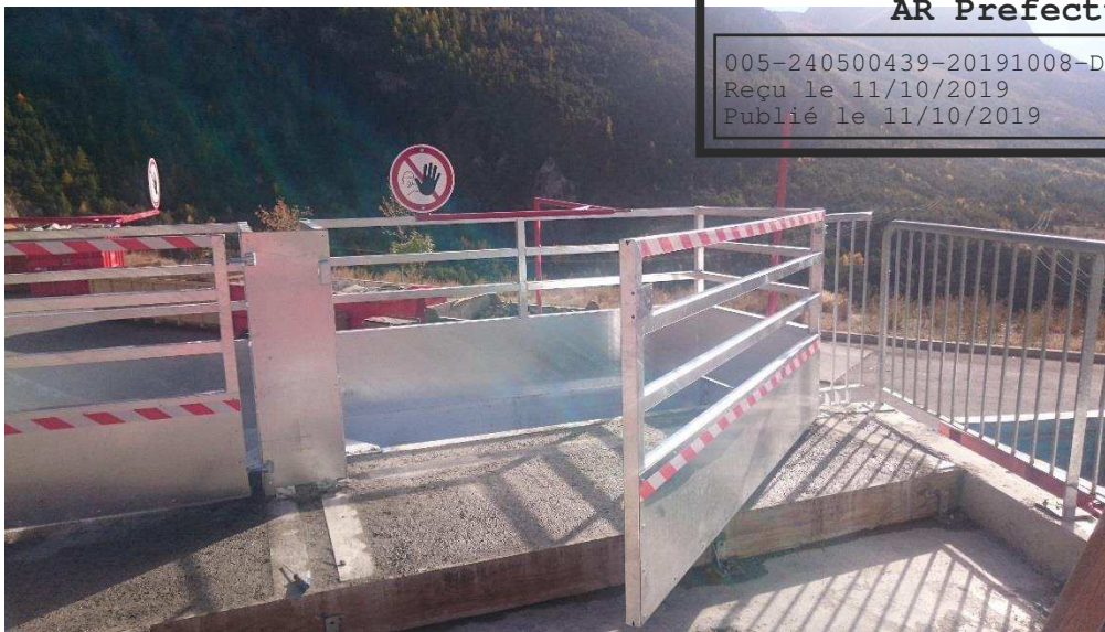
Système de sécurisation des hauts de quai - Déchèterie de Fonchristiane
