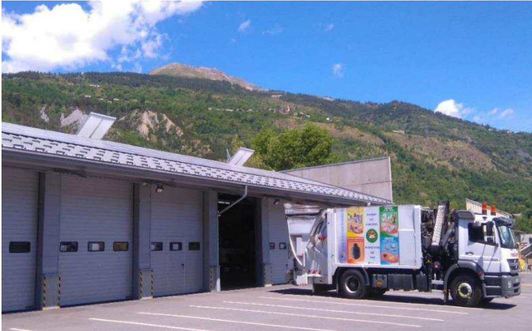
Hangar OM, Z.A de Pont la Lame à Puy-st-André
