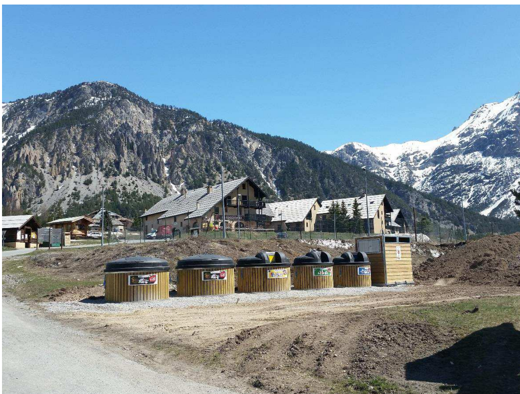
Point de collecte en DSE du Roubion (commune de Névache)
