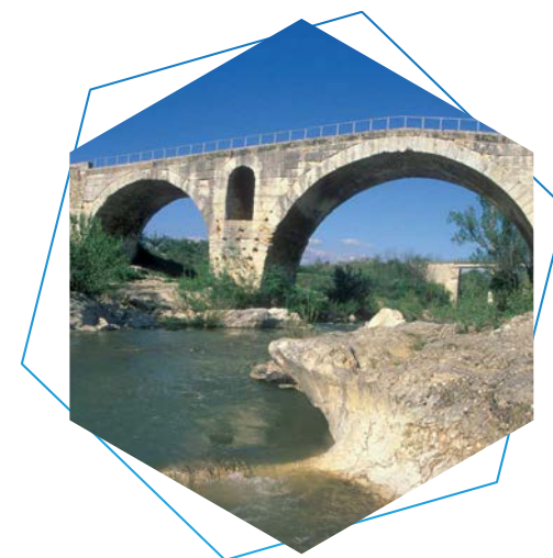
Pont Julien, Calavon-Coulon
