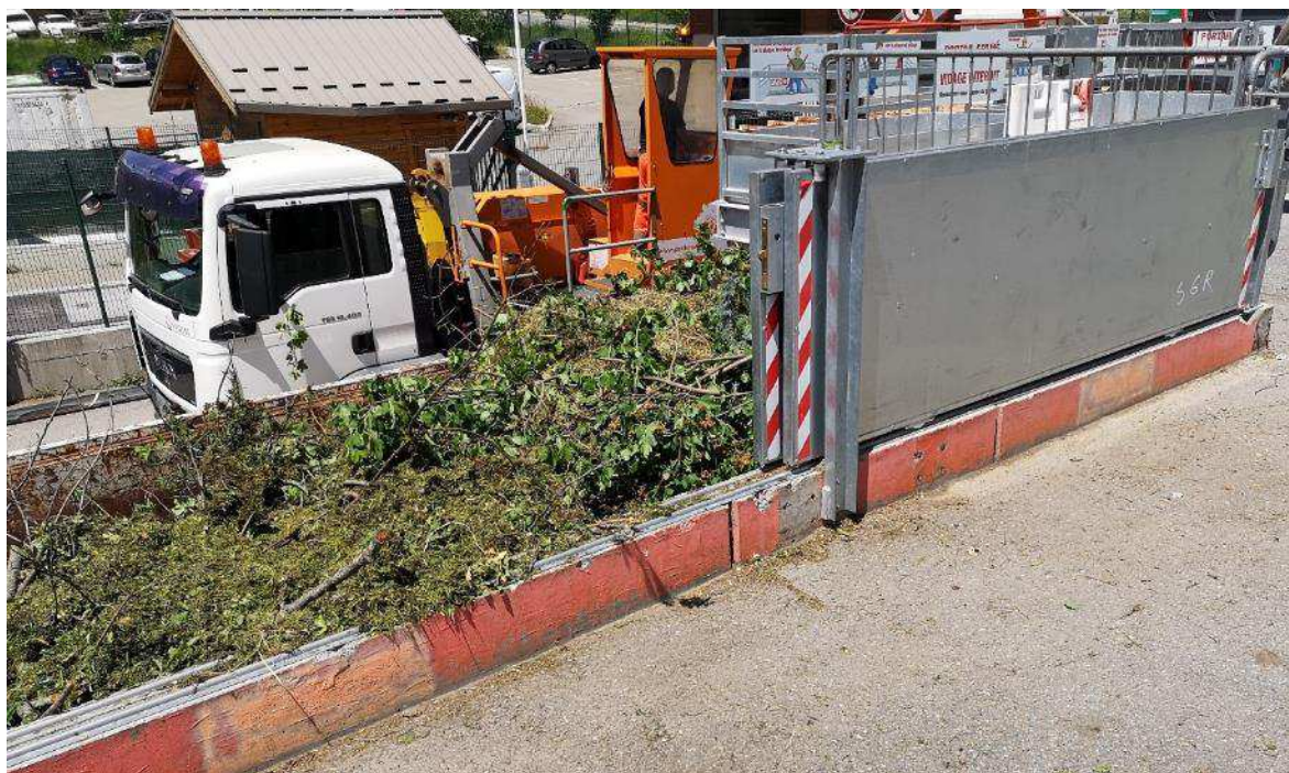
Système de sécurisation – haut de quai des déchets - Déchèterie de Clos Jouffrey
