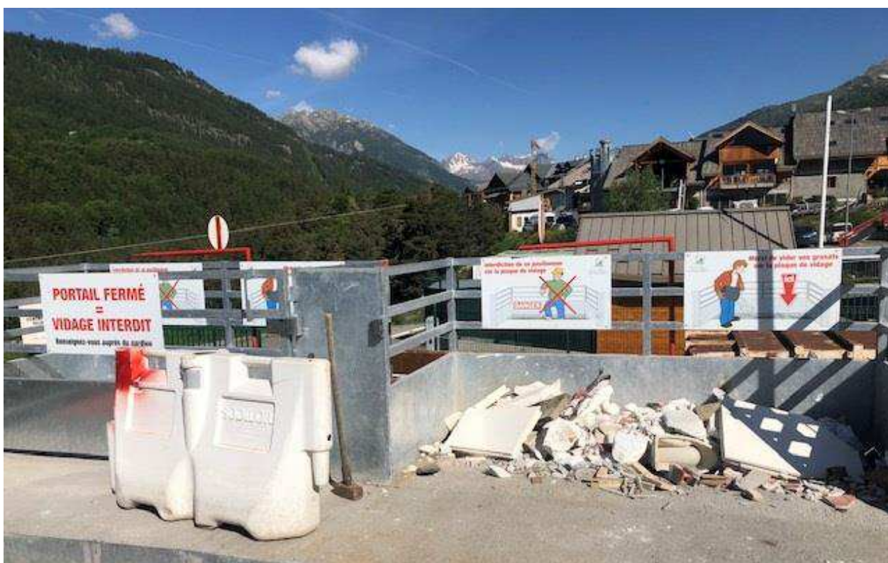
Système de sécurisation –haut de quai des gravats hauts de quai - Déchèterie de Clos Jouffrey
