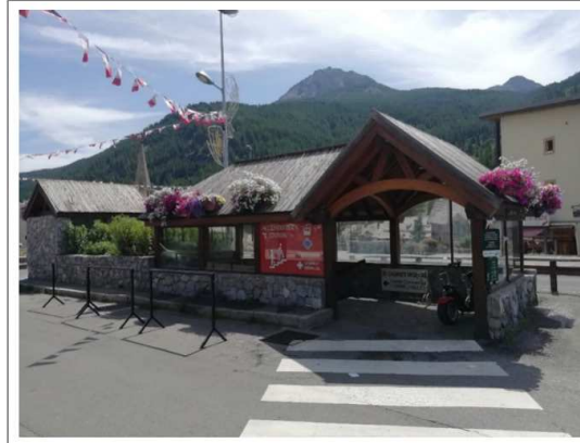
Entrée du passage piéton de Chantemerle peu visible
