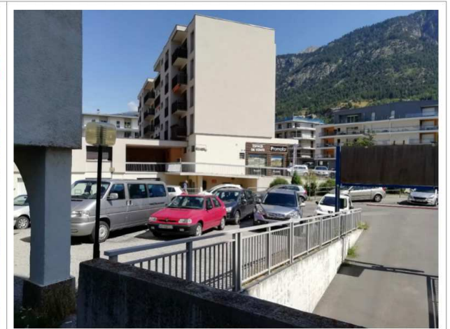
Voirie aux alentours fortement sollicitée
