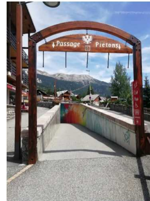
Entrée côté front de neige, avec une bonne visibilité
