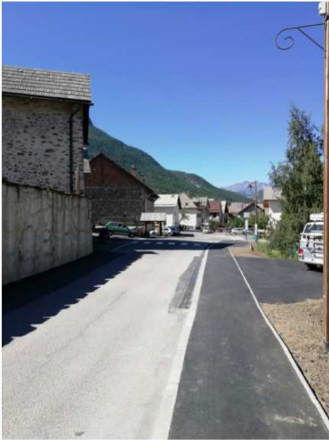
Rétablissement d'un trottoir à l'occasion de travaux neufs
