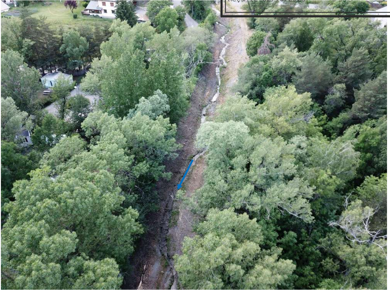
Figure 14 : Photographie aérienne du tronçon amont RN 94
