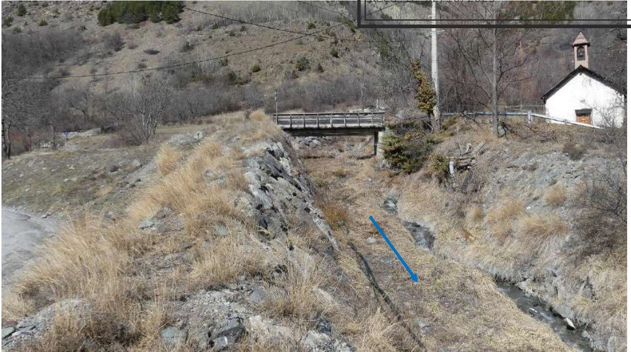
Figure 9 : Photographie du tronçon "Travaux RTM"
