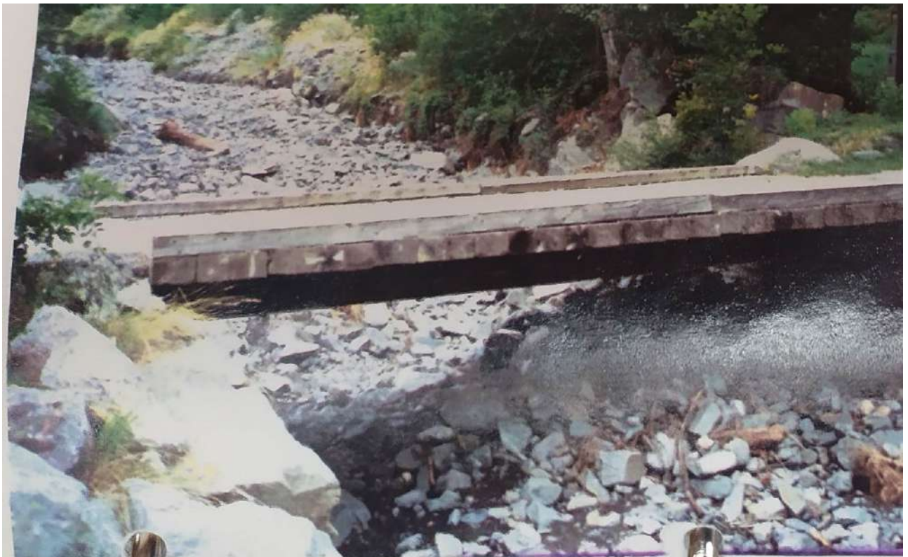
Photo 42 : Charriage en amont du pont de la Vignette Basse en 1995
