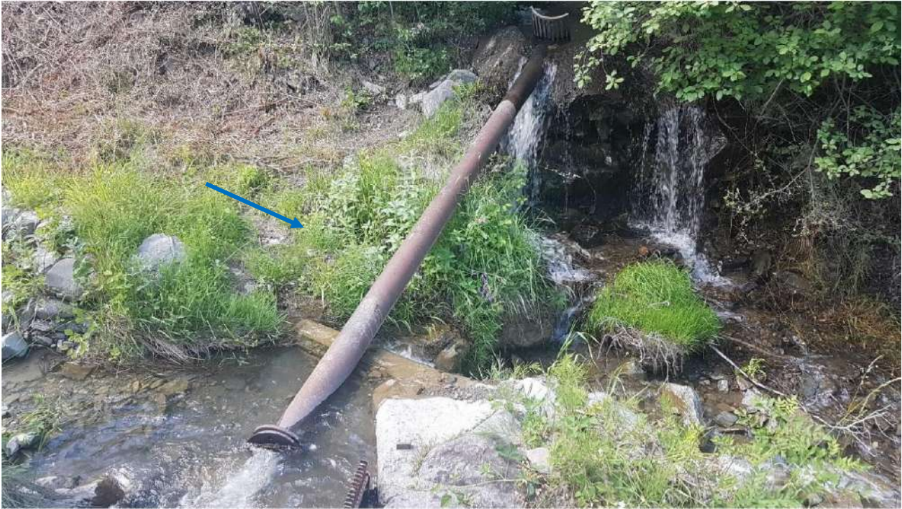
Figure 116: Seuil et conduite de traversée du canal
