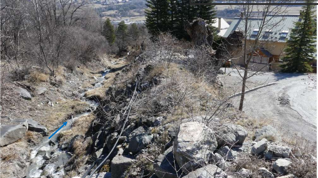
Figure 87 : Photographie du tronçon intermédiaire
