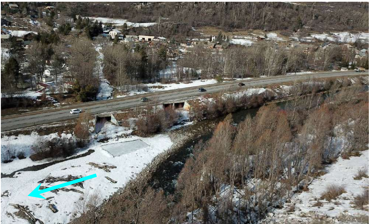
Photo 38 : Franchissement de la RN 94
