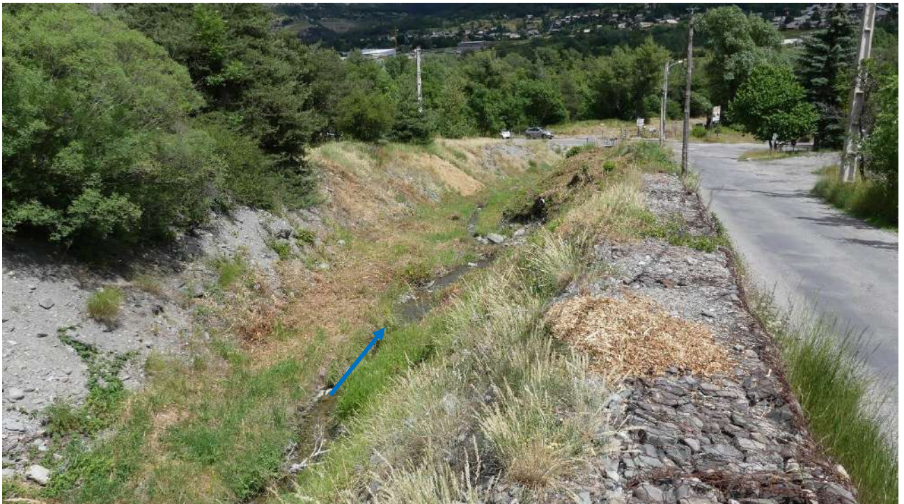
Figure 13 : Photographie de la rangée de gabions longeant la route – tronçon aval en amont du pont de la RN 2094
