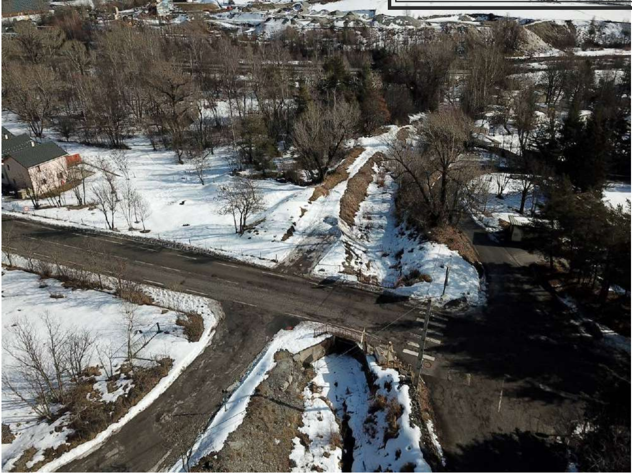
Photo 36 : Pont de la RN 2094 et lit aval
