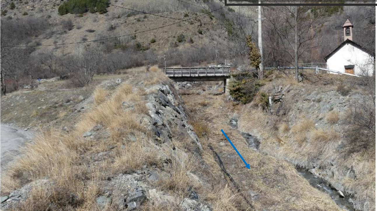
Figure 24 : Photographie du tronçon "Travaux RTM"
