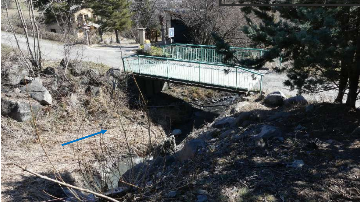
Figure 110: Pont de la Vignette Basse
