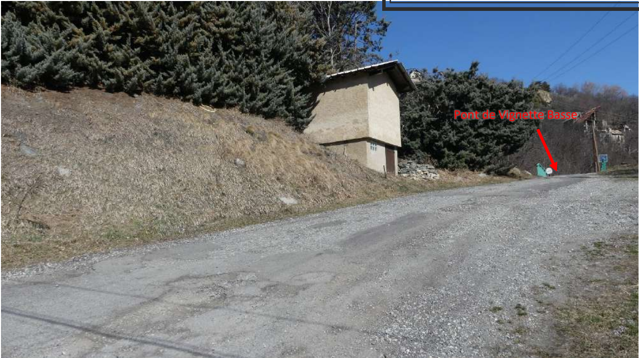
Figure 89 : Photographie de la zone en remblai
