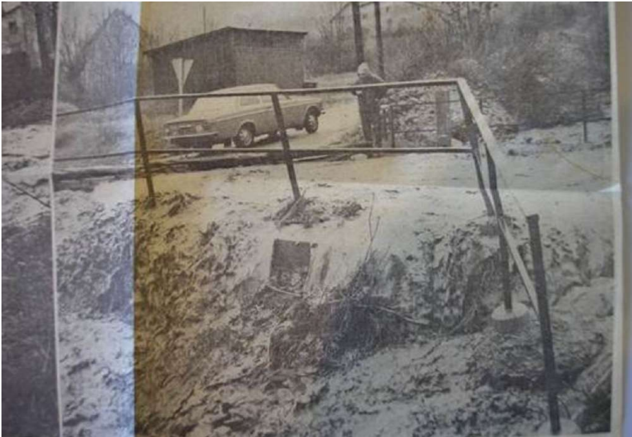
Figure 40 : Crue de 1973 au niveau du pont de la RN 94
