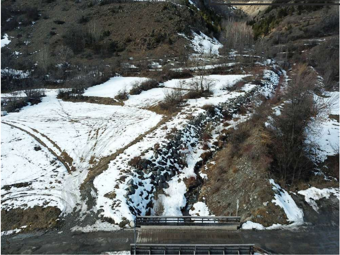
Photo 18 : Vue d'ensemble du tronçon en amont du Rif Claret
