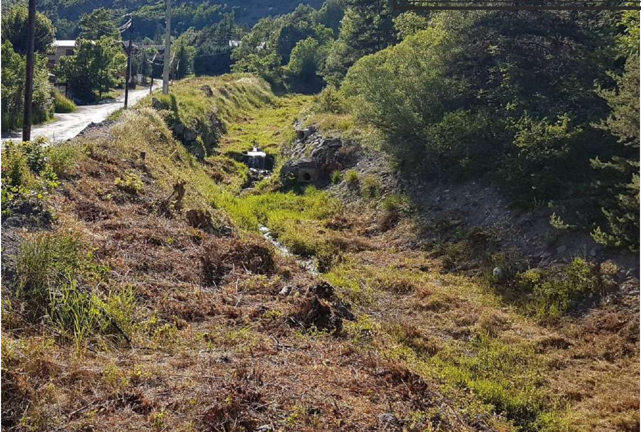
Photo 33 : Seuil et rupture de pente
