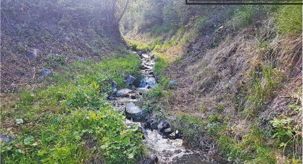
Photo 28 : Absence de trace de crue en aval du seuil
