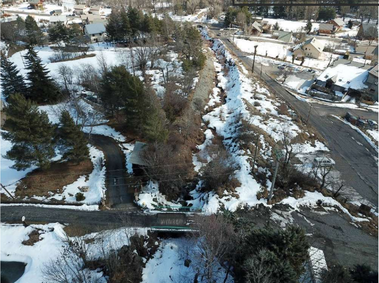
Photo 32 : Lit aval, toujours trop étroit pour permettre une régulation du transport solide
