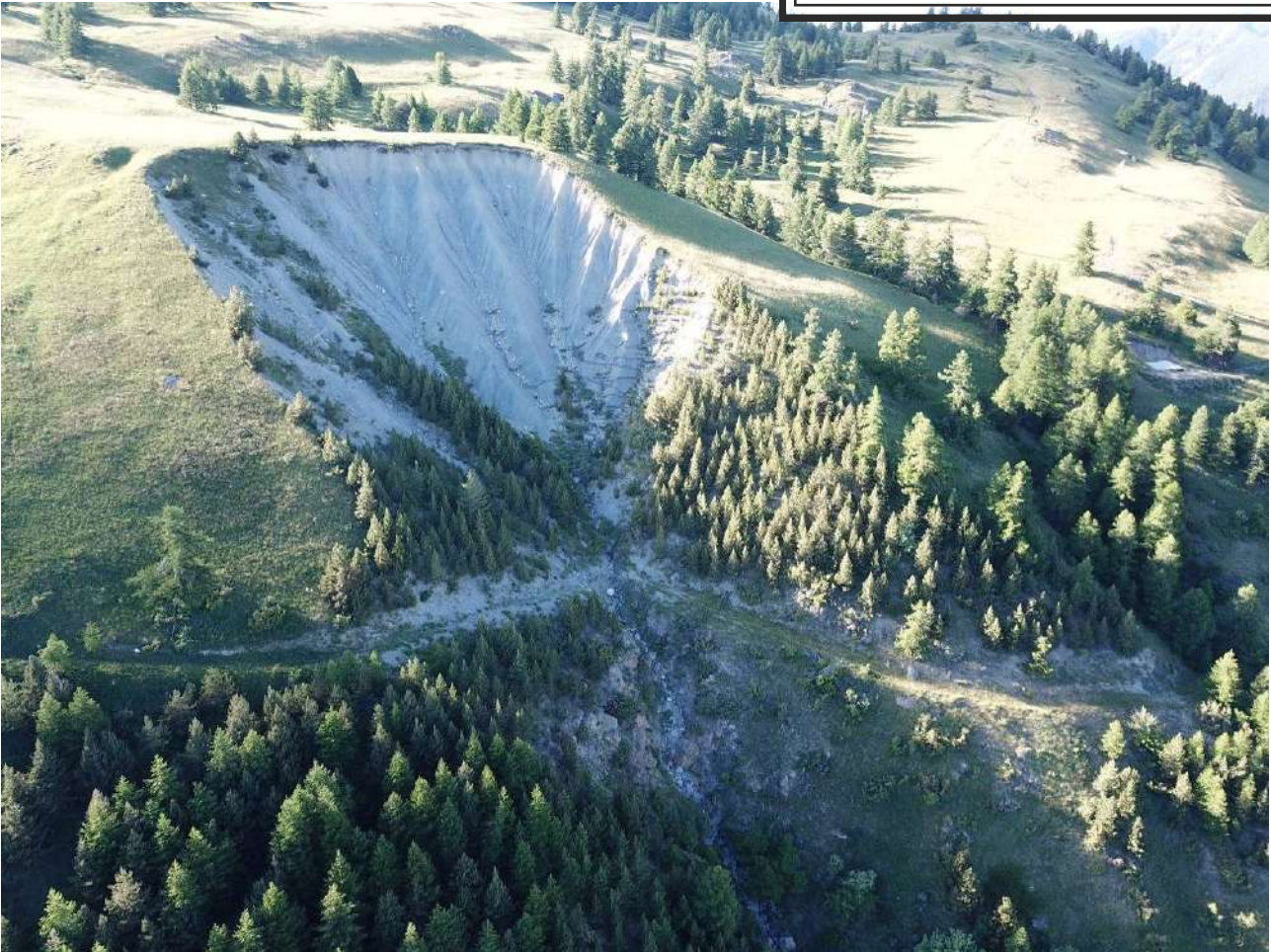
Photo 1 : Alpage et zone d'érosion amont
