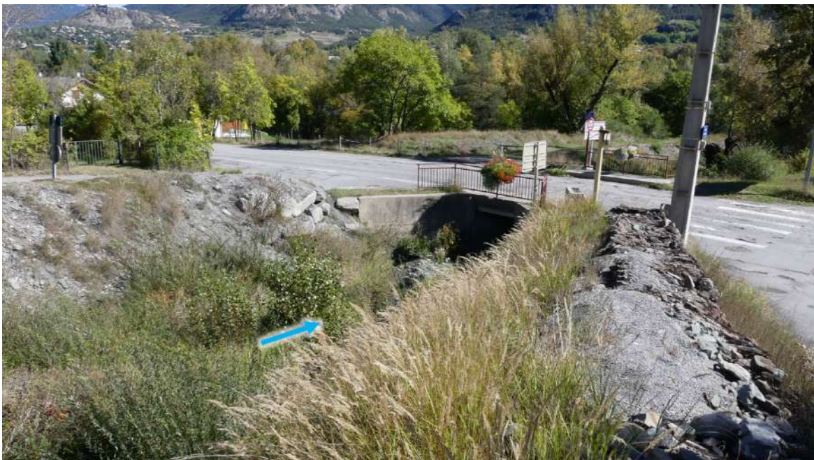
Figure 143 : Digue en amont immédiat de l'ouvrage de la RN 2094
