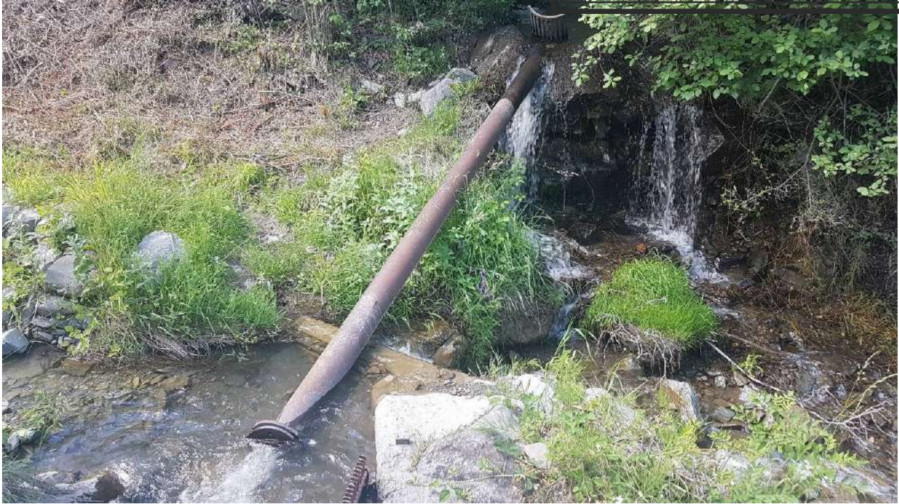
Photo 26 : Seuil et conduite de traversée du canal
