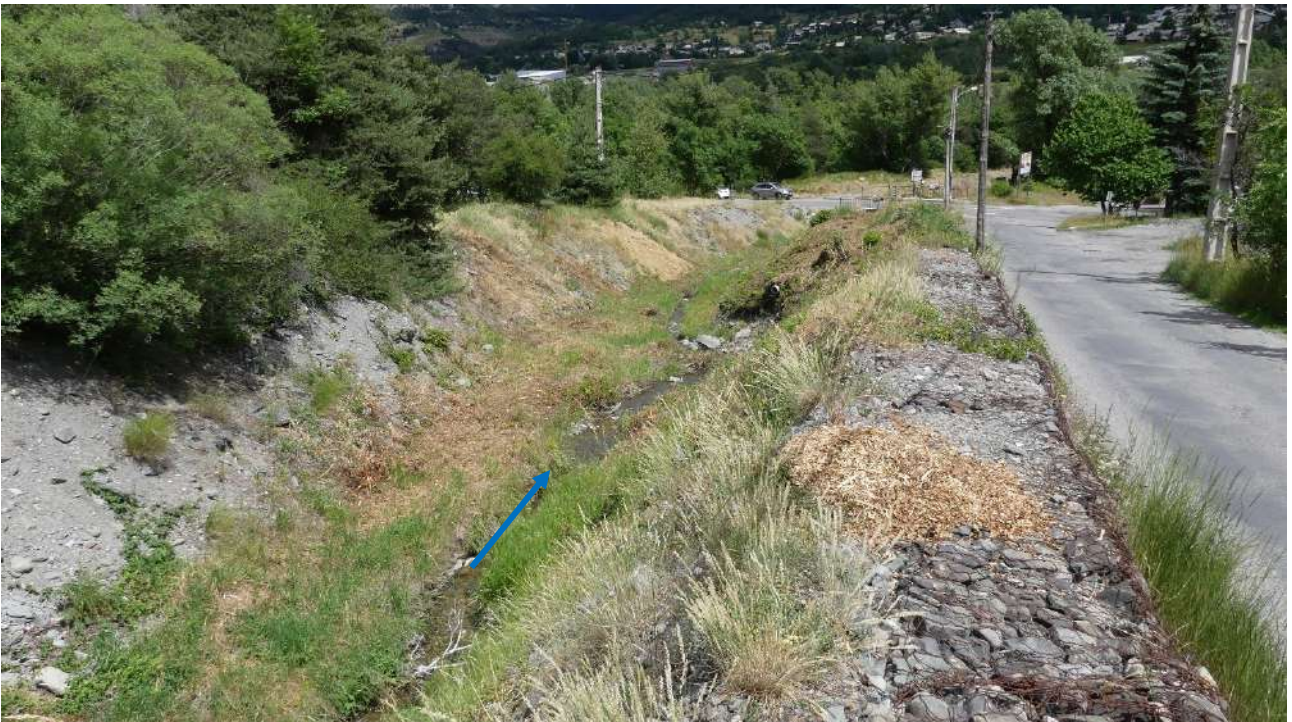
Figure 28 : Photographie de la rangée de gabions longeant la route – tronçon aval en amont du pont de la RN 2094
