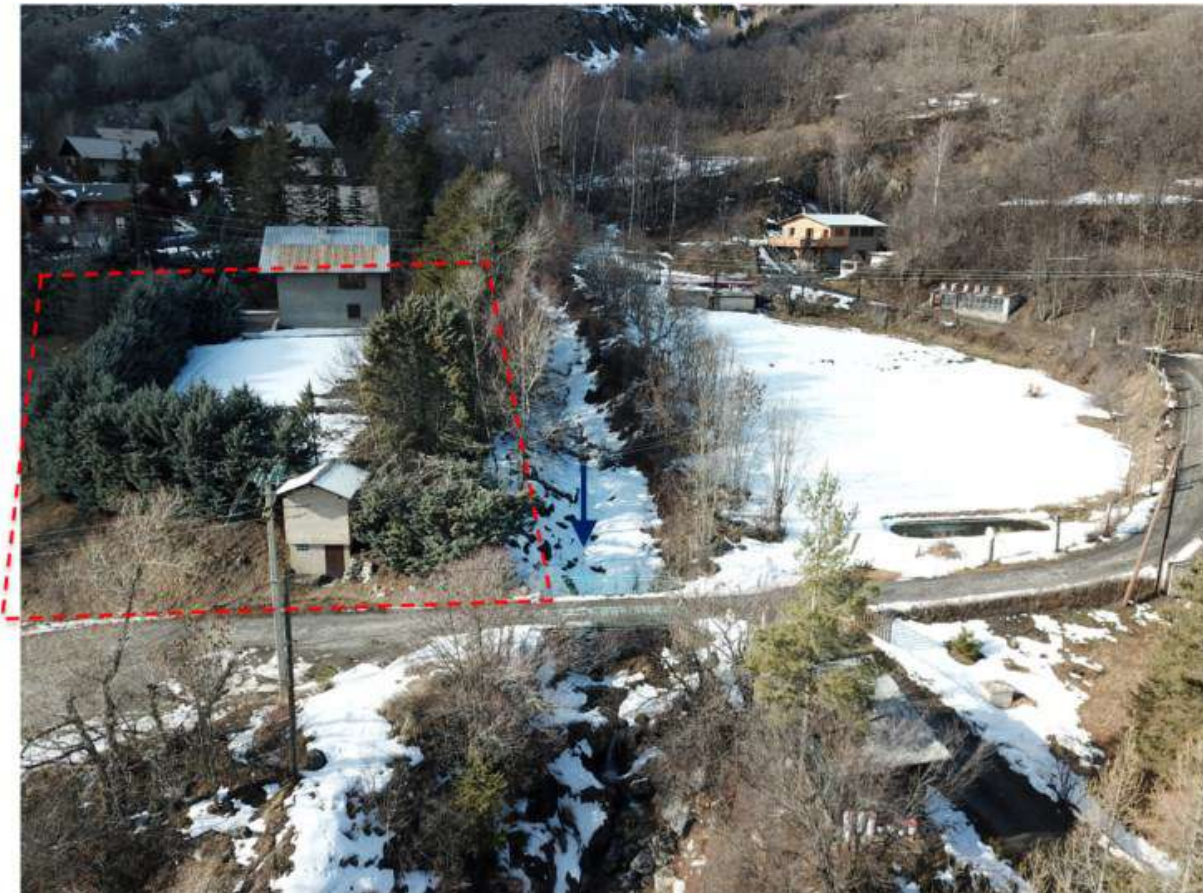
Figure 90 : Localisation de la zone en remblai
