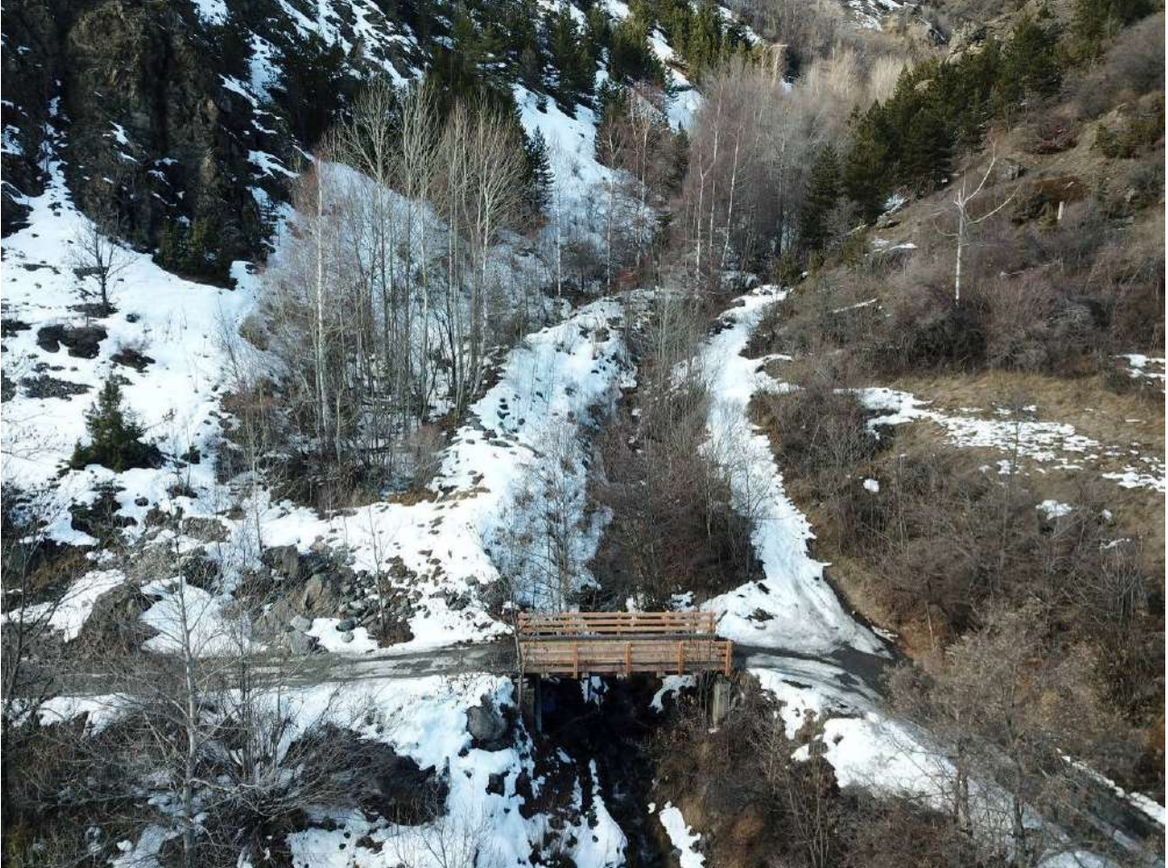
Photo 16 : Limite aval de la zone de transition et sommet du cône de déjection
