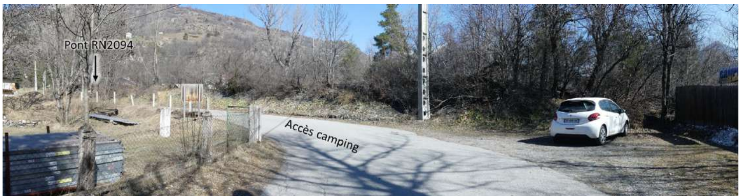
Figure 102 : Digue du tronçon amont RN 94 vue de l'accès au camping en rive droite
