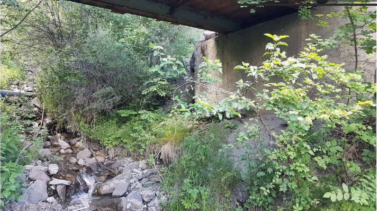
Photo 17 : Culée rive gauche sous le pont amont
