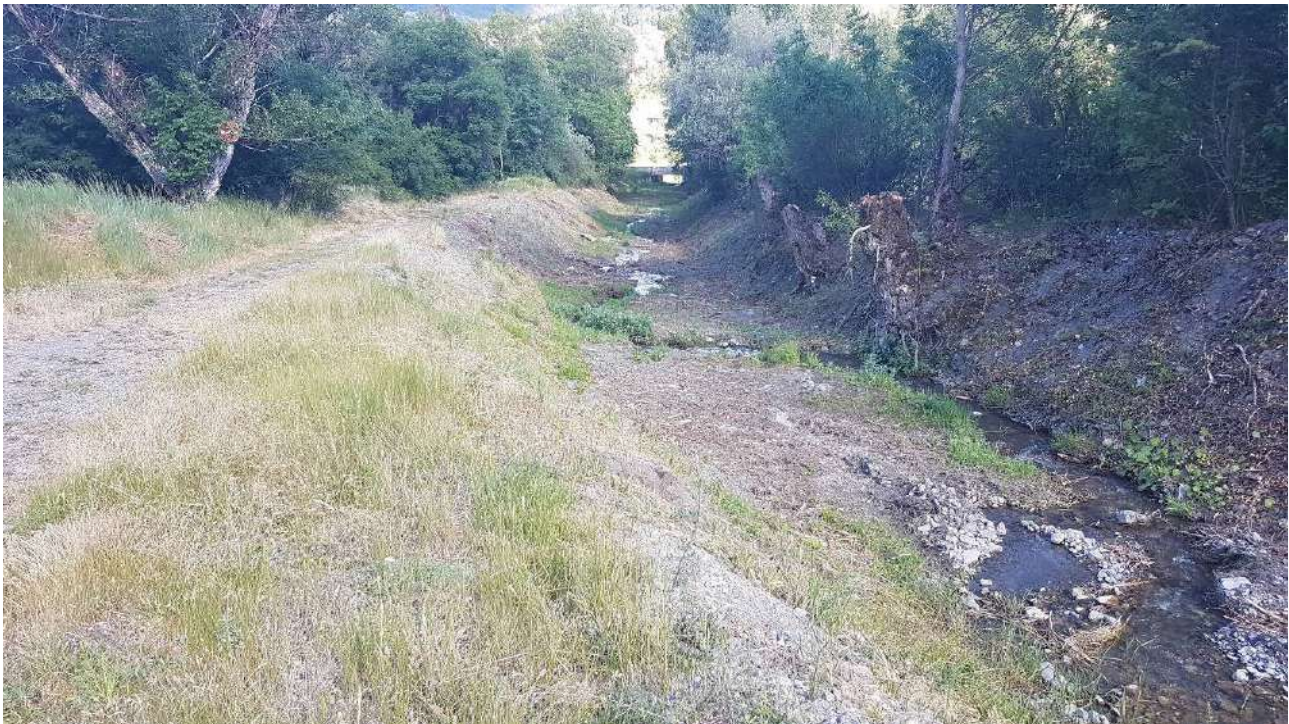
Photo 37 : Faible pente et dépôt dans le lit aval
