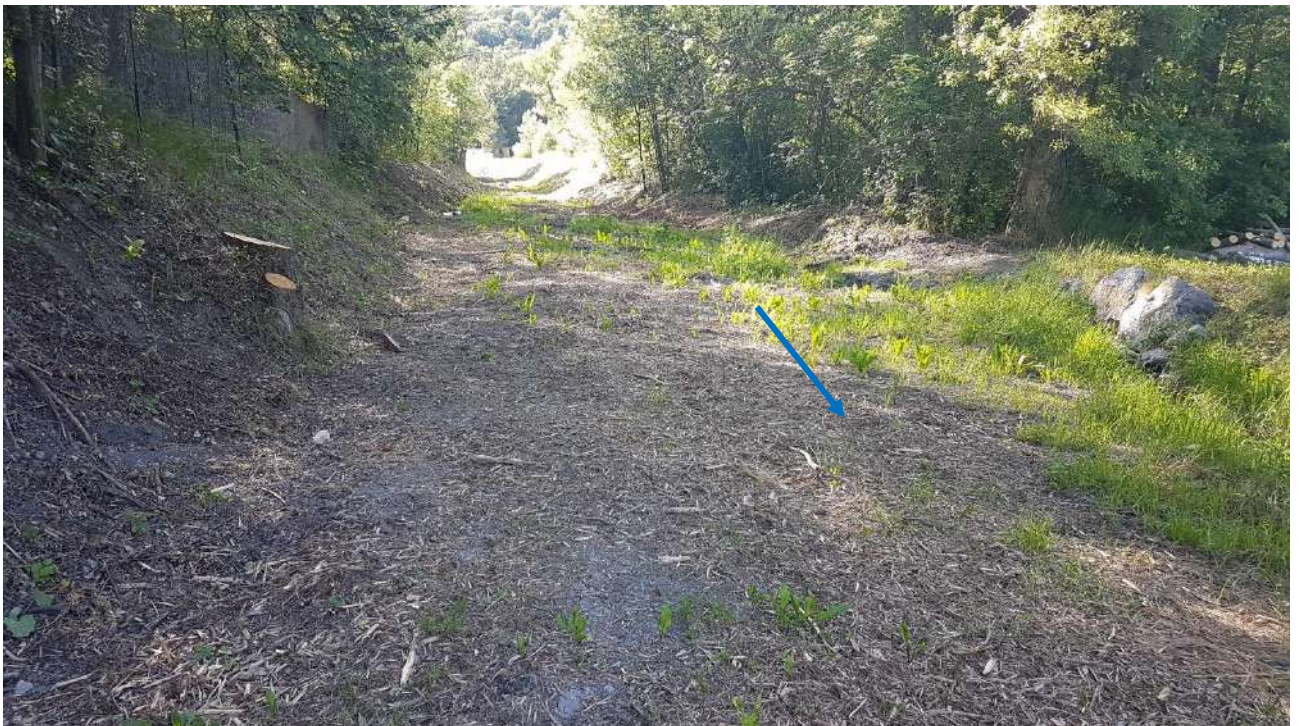
Figure 15 : Photographie du tronçon amont RN 94
