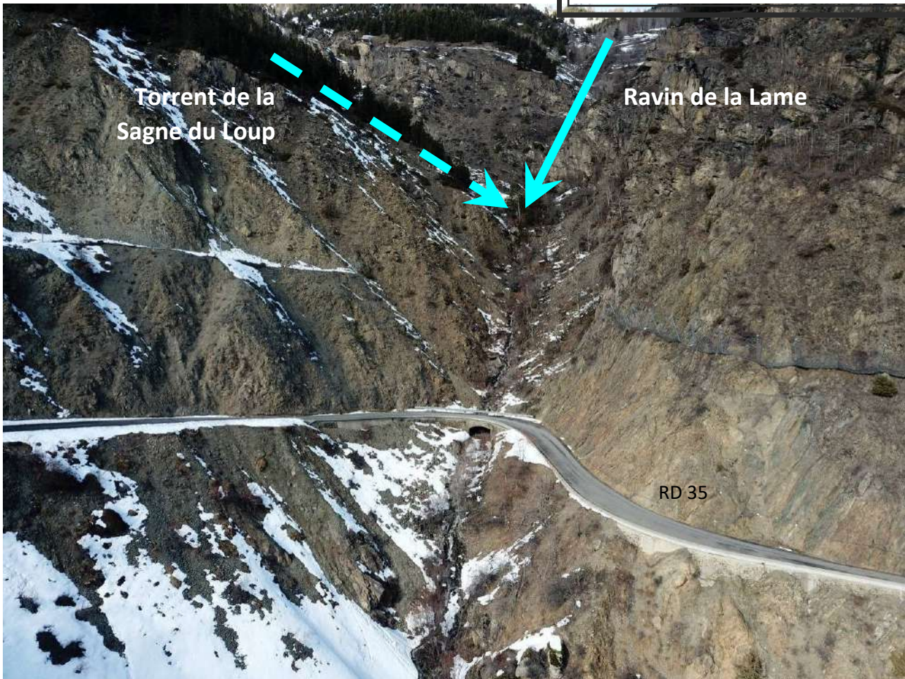
Photo 10 : Formation du torrent de la Fossa depuis l'amont
