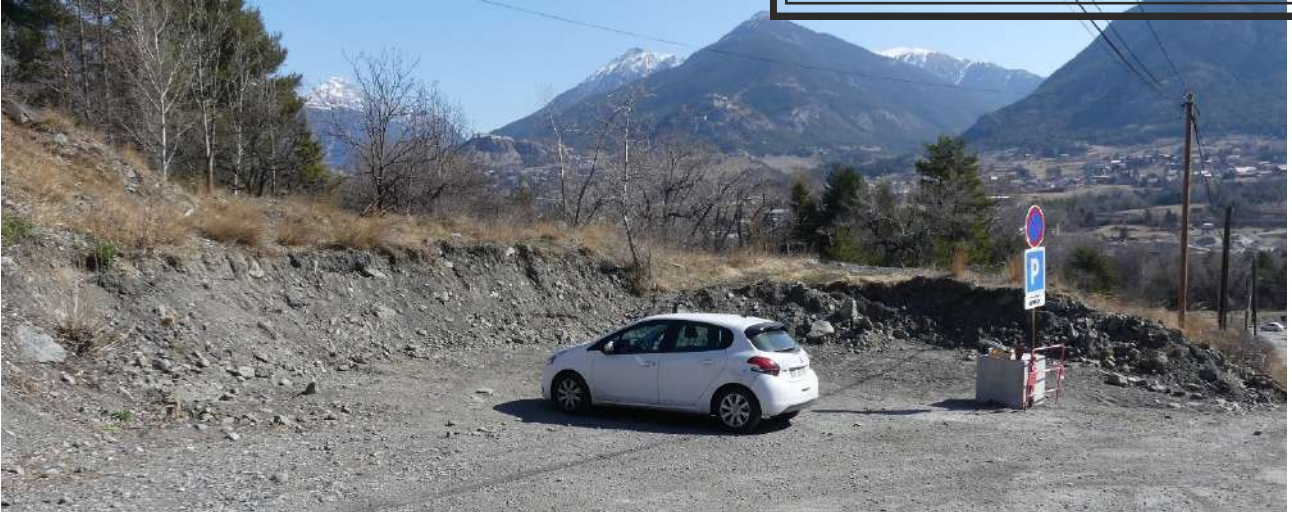
Figure 124 : Raidissement du talus aval en aval du pont de Vignette Basse
