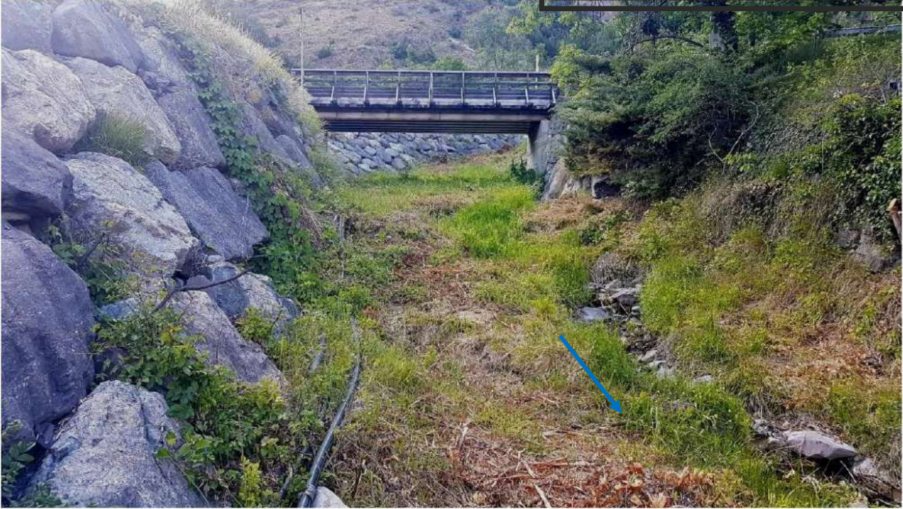
Figure 108: Aval du pont du Rif Claret
