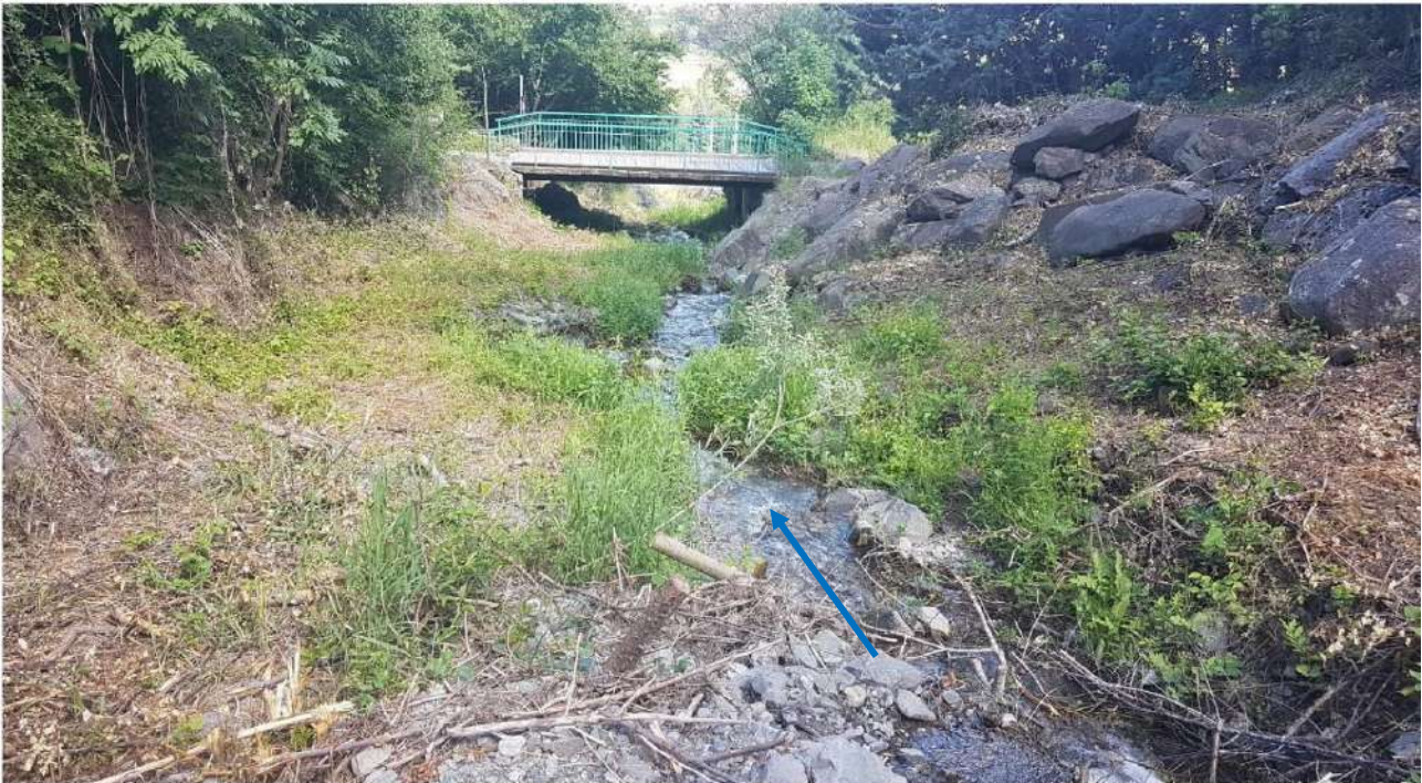
Figure 109: Pont de la Vignette Basse
