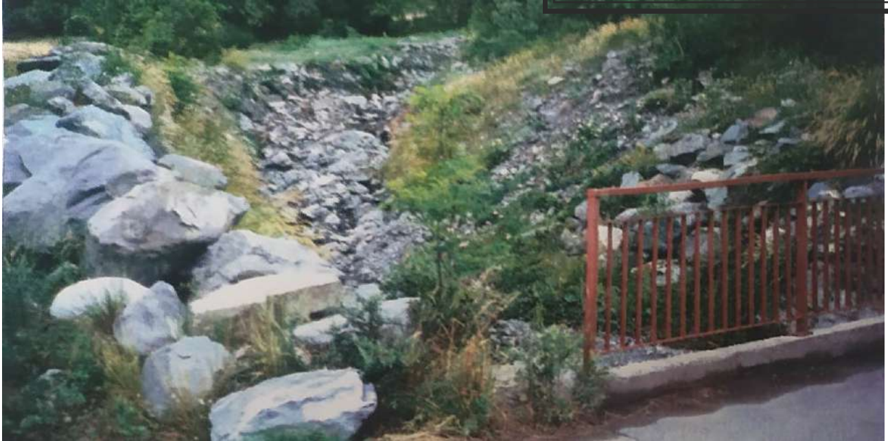
Photo 41 : Amont de l'ancien pont de Rif Claret et trace d'un petit charriage
