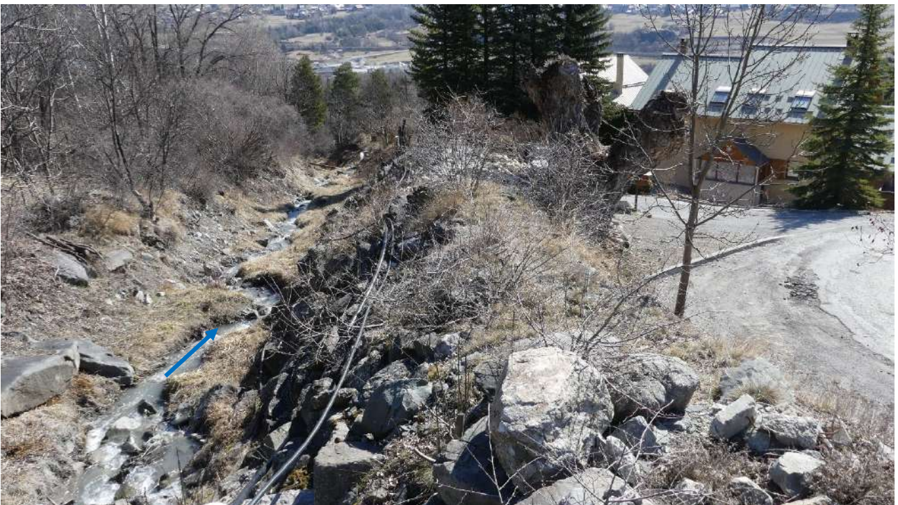
Figure 25 : Photographie du tronçon intermédiaire
