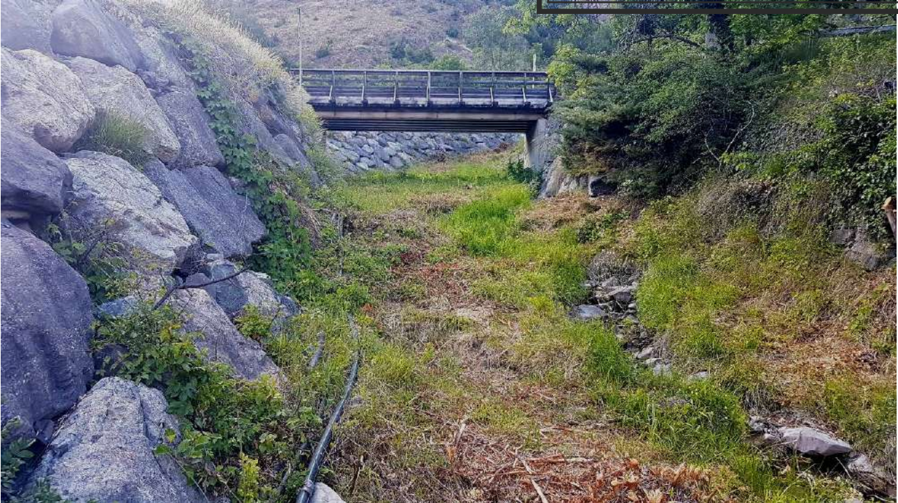
Photo 23 : Aval du pont du Rif Claret avec réduction de pente sans dépôt ordinaire
