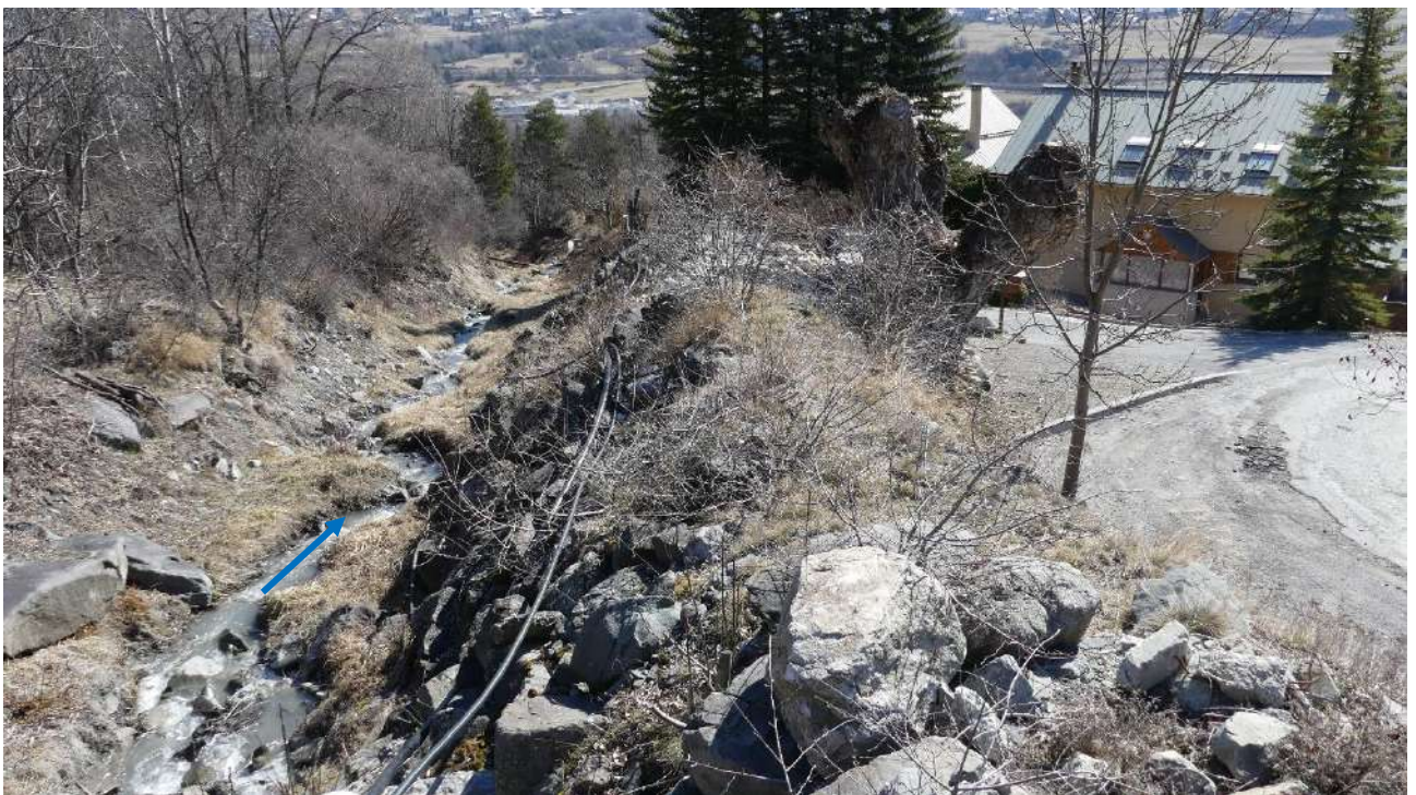
Figure 10 : Photographie du tronçon intermédiaire
