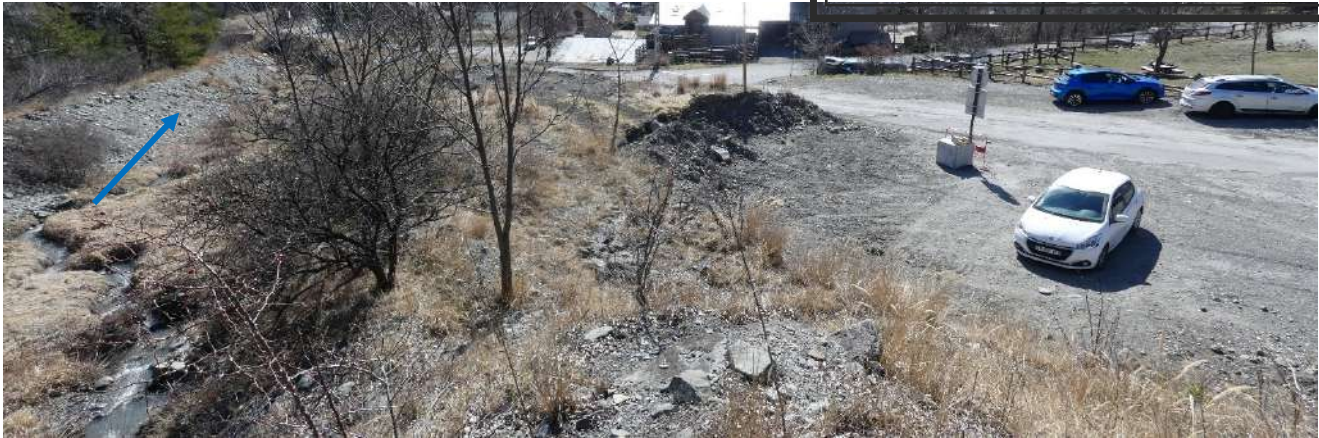
Figure 96 : Partie amont du tronçon aval, vue de l'amont
