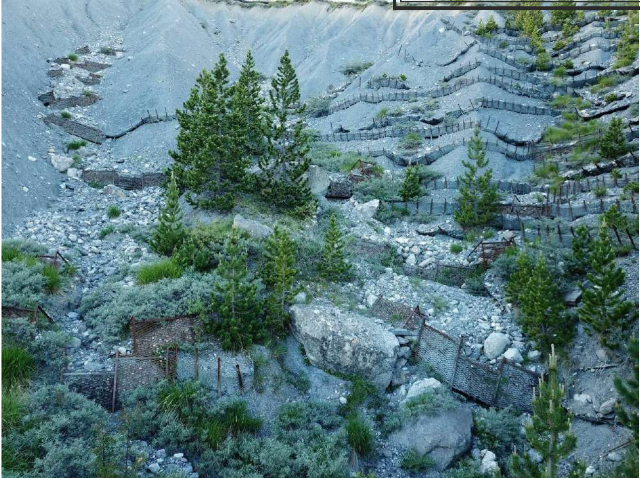
Photo 2 : Zone d'érosion du Ravin de la Lame et correction partielle
