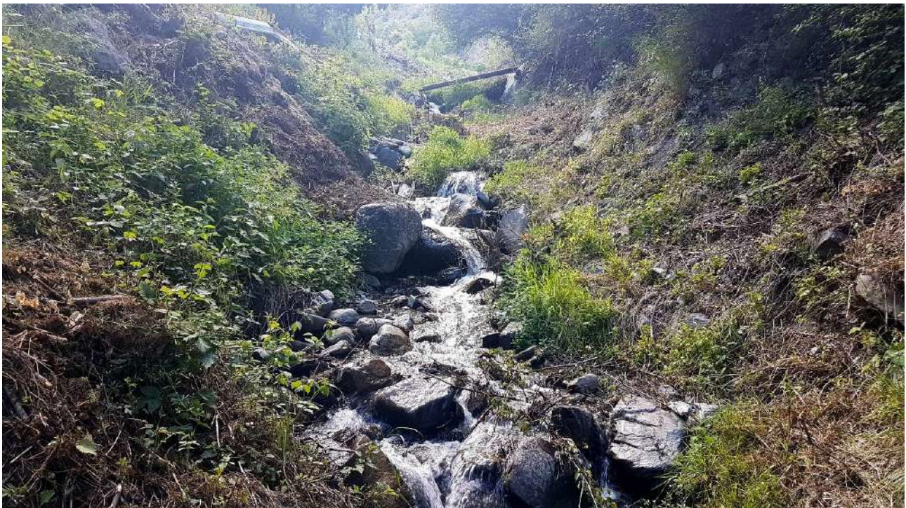
Photo 27 : Lit étroit et profond en aval du seuil du canal
