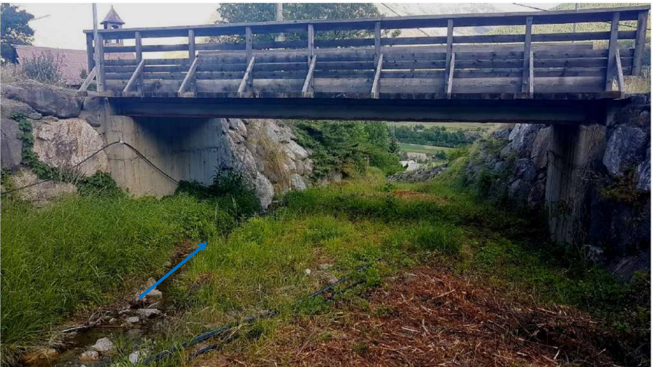
Figure 107: Pont du Rif Claret vu de l'amont
