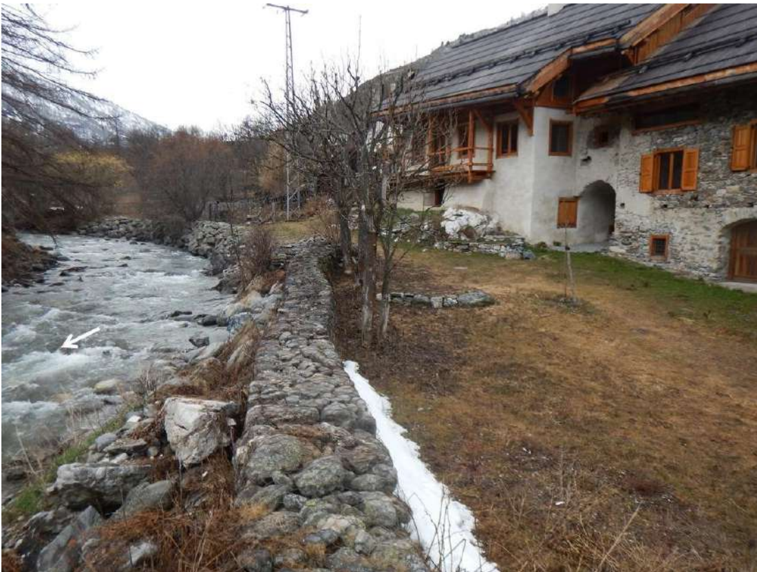
Figure 15 : Digue de Ville Haute - vue vers l'amont au droit de P9 (P8b étant au niveau des arbres en pied du gabion)
