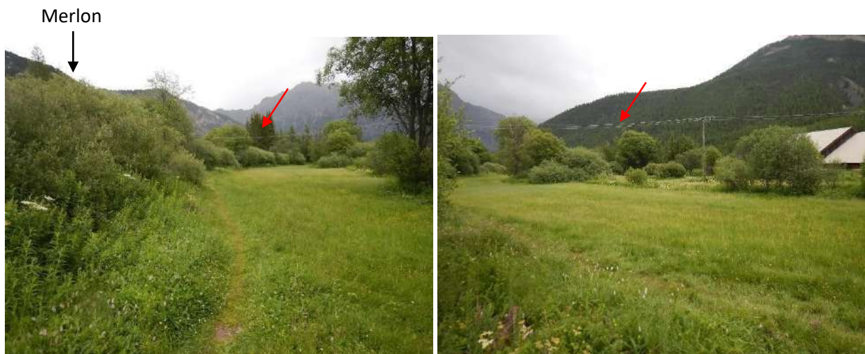
Figure 68 : Ligne aérienne HTA vue depuis l'aval rive droite du pont de Ville Basse, vers l'aval
