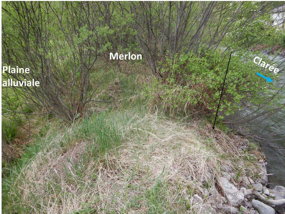
Figure 61 : Merlon au niveau de P31, vu de l'aval
