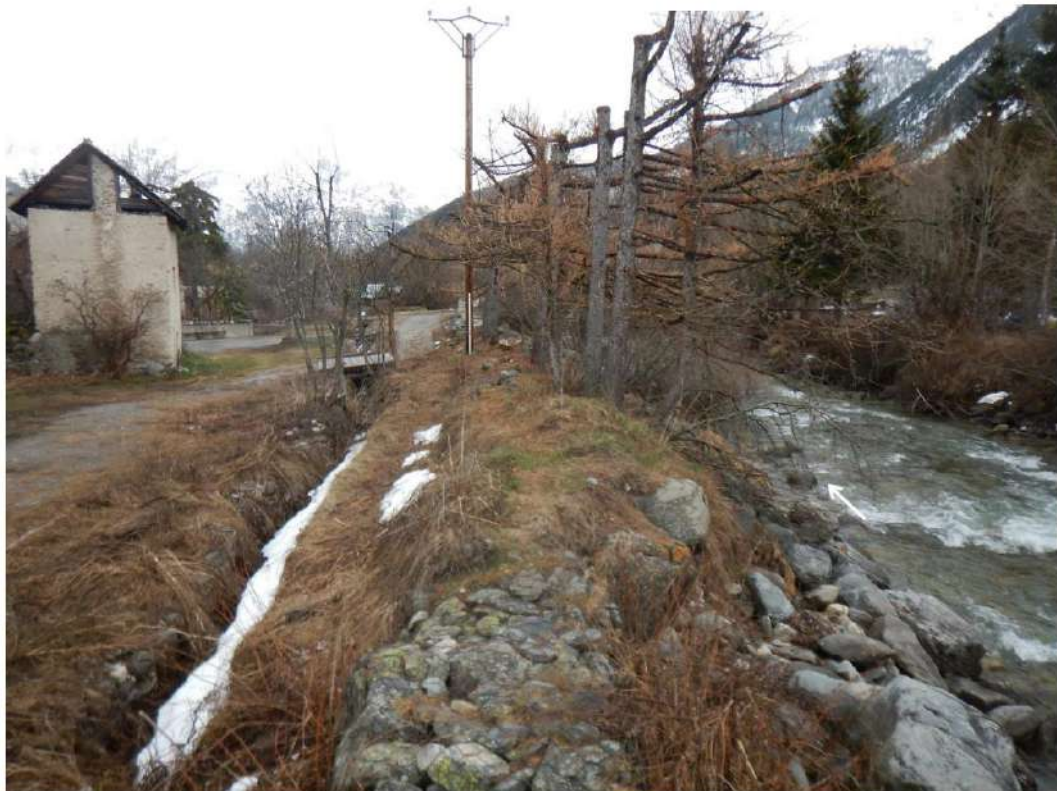
Digue de Ville Haute - Vue vers l'aval en amont du profil P9a
