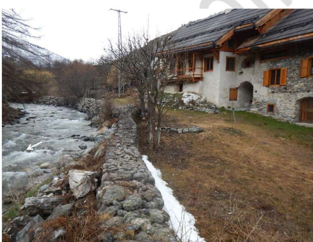
Digue de Ville Haute - vue vers l'amont au droit de P9 (P8b étant au niveau des arbres en pied du gabion)
