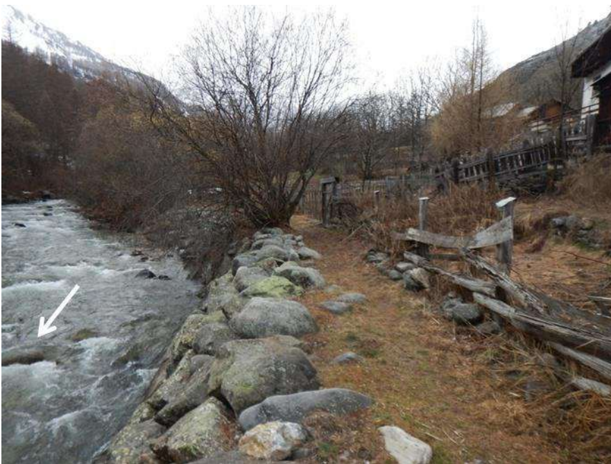
Figure 9 : Digue de Ville Haute - enrochements au droit du profil 8, vue vers l'amont
