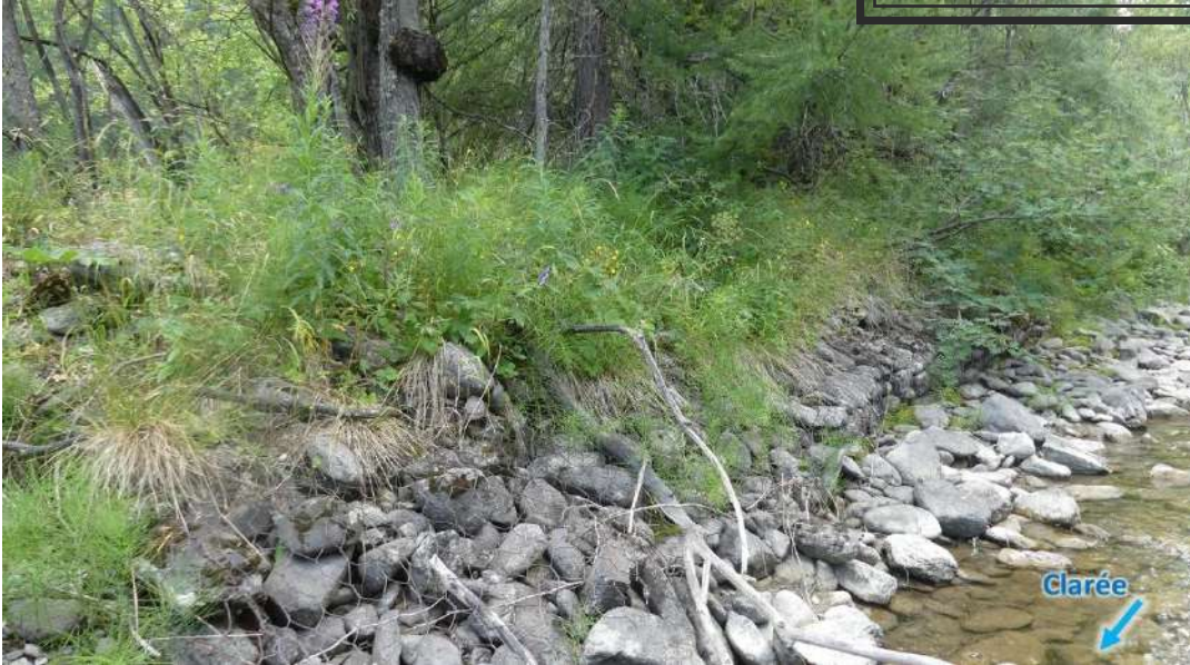
Figure 53 : Zone de la Gravière - gabion rive droite vers P25
