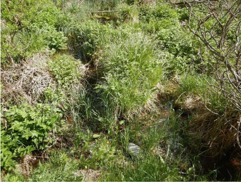
Figure 72 - Terrains gorgés d'eau en contrebas du merlon (amont P27, en rive droite, mai 2022)
