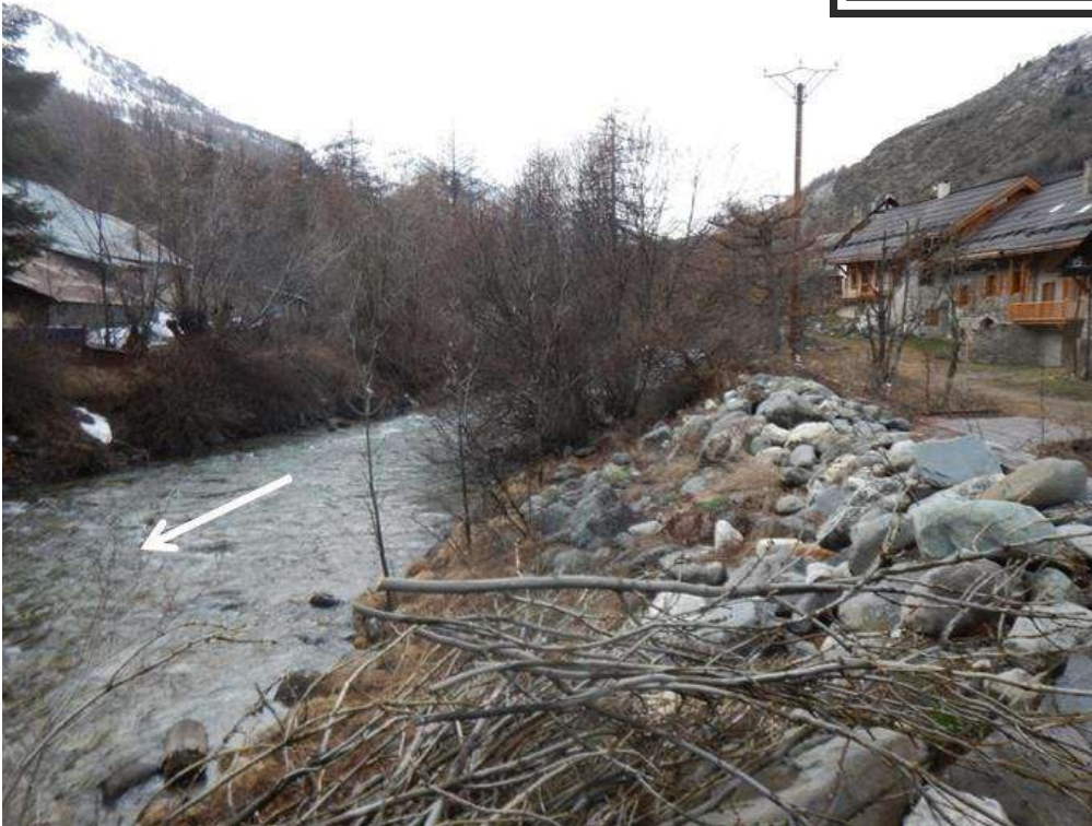
Figure 18 : Digue de Ville Haute - vue vers l'amont vers le profil P11
