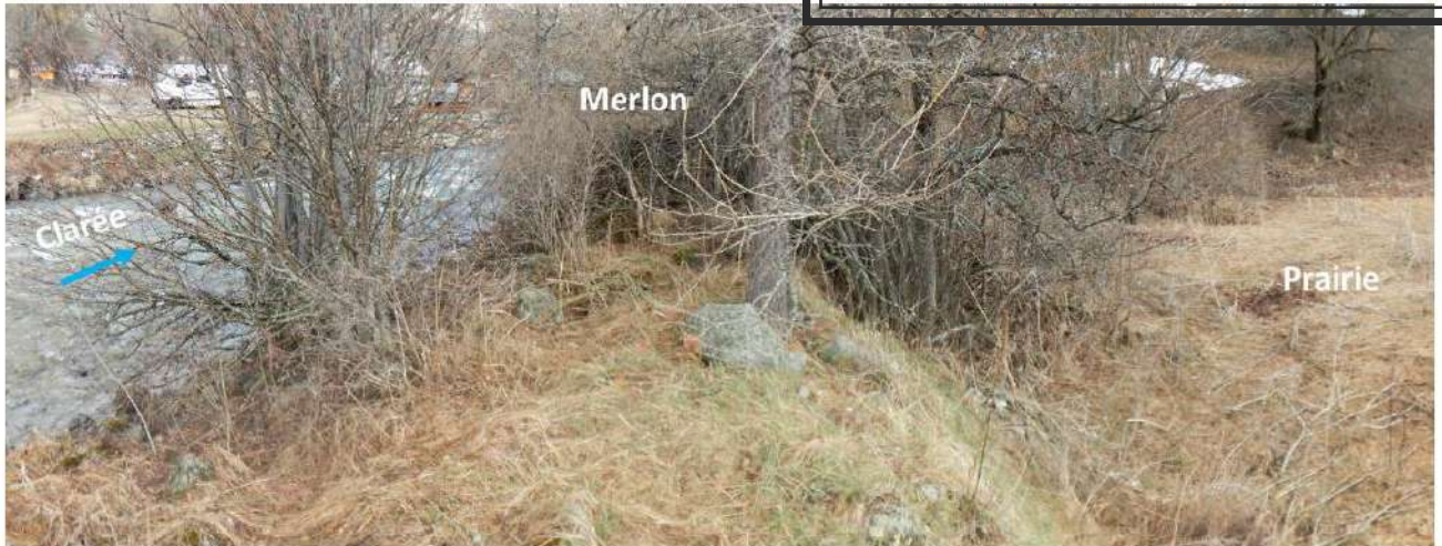
Vue locale du merlon (depuis l'amont) en aval du profil 18
