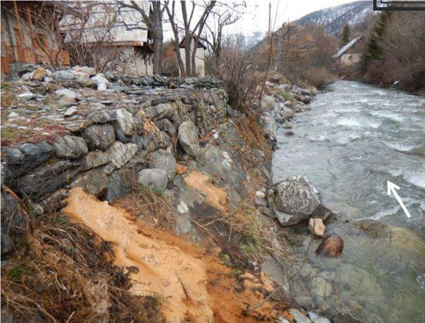
Figure 12 - Digue de Ville Haute - vue vers l'aval au droit du profil 8a
