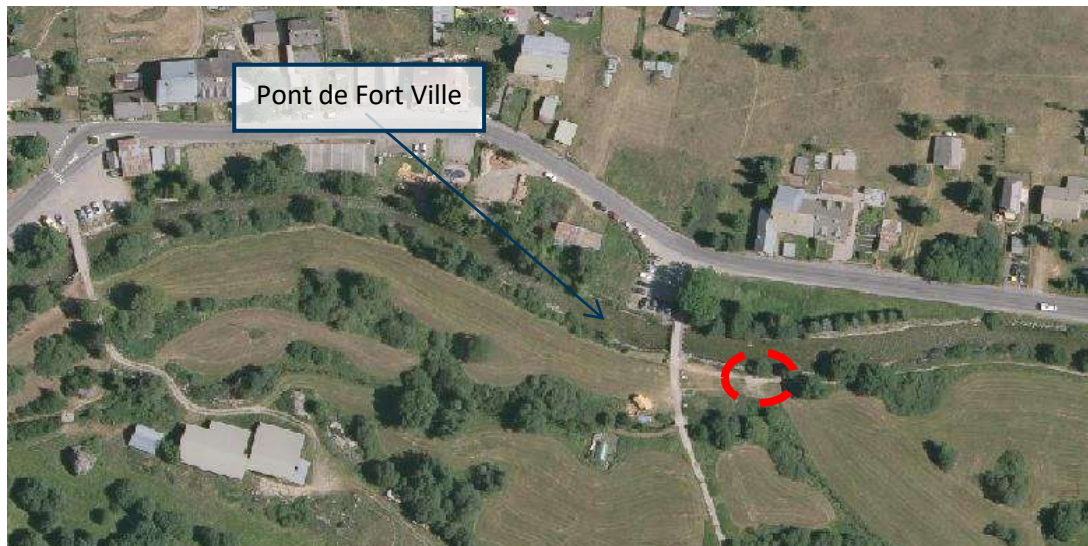
Figure 81 : Vue de la zone de premier débordement
