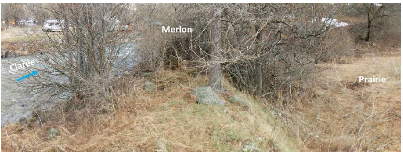
Figure 32 : Vue locale du merlon (depuis l'amont) en aval du profil 18
