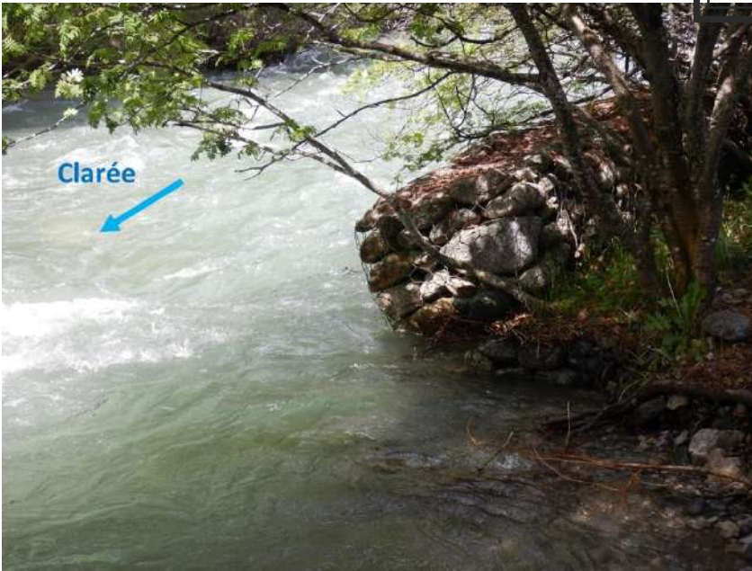
Figure 51 : Zone de la Gravière - extrémité aval du gabion rive gauche
