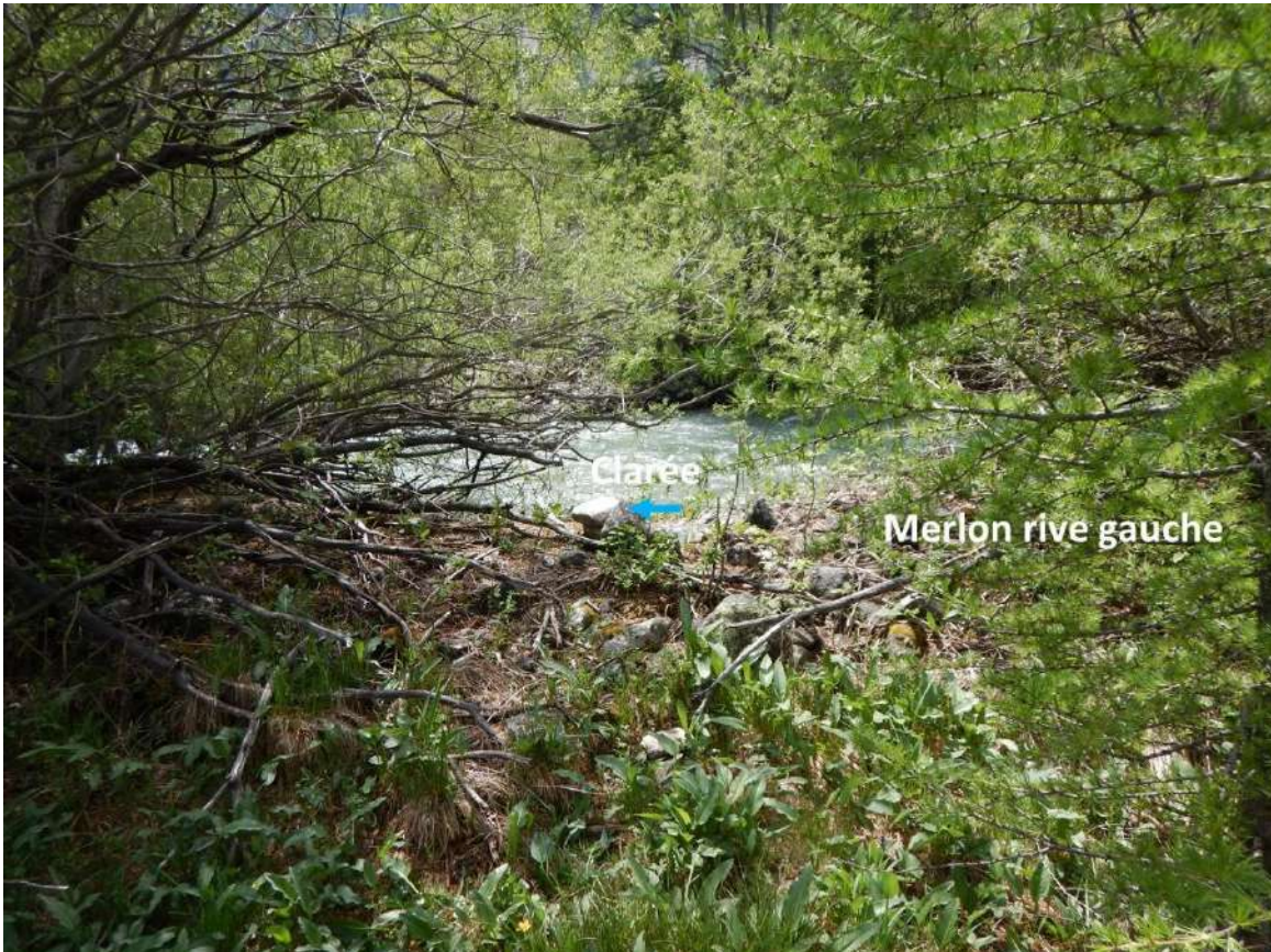
Figure 48 : Merlon rive gauche au niveau de P25, vu de la rive gauche
