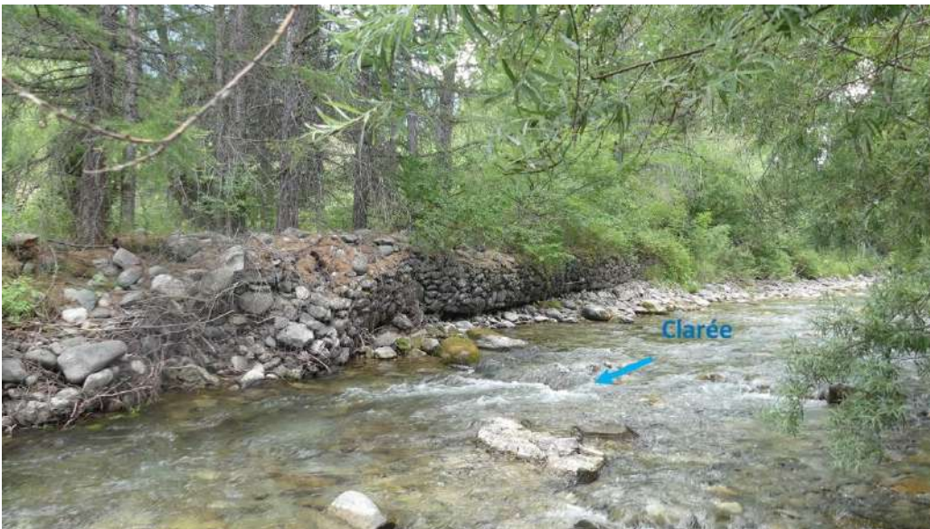
Figure 52 : Zone de la Gravière - gabion rive droite vers P23b
