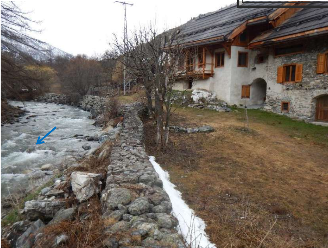
Figure 20 : Vue (vers l'amont) du tronçon le moins résistant
