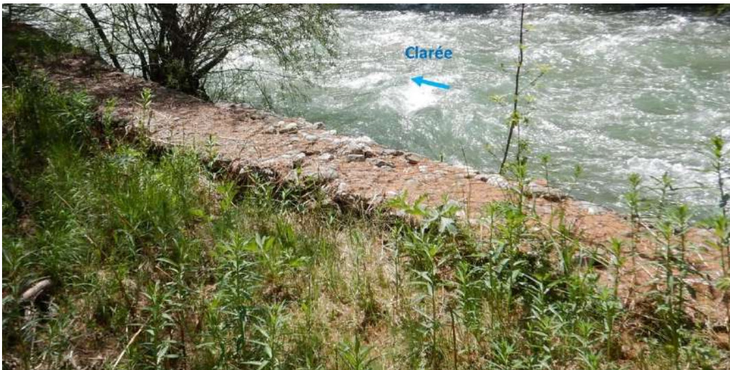
Figure 50 : Zone de la Gravière - gabion rive gauche
