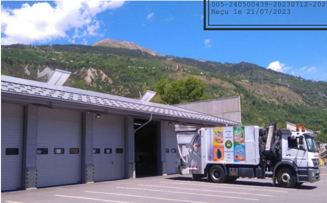
Hangar OM, Z.A. Pont la Lame à Puy-Saint-André
