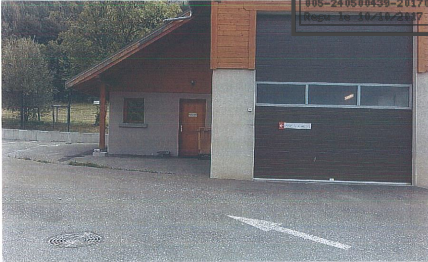
Locaux techniques et administratifs de la fourrière
